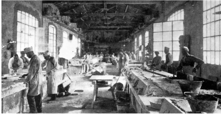
Fig. 32. Foto con lavorazione mattoni e materiali per edilizia
